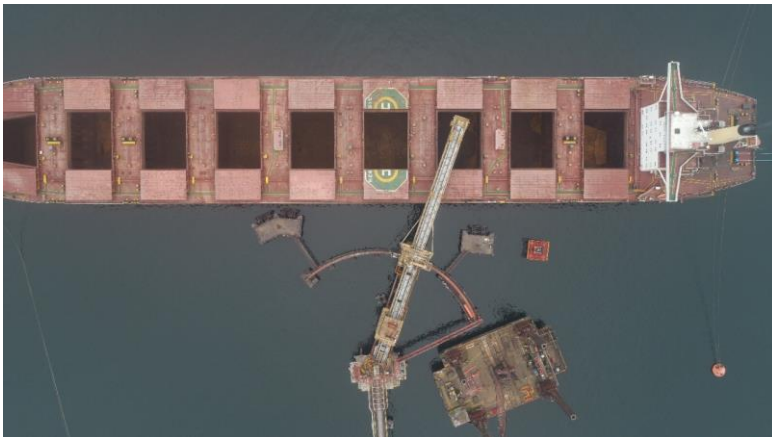
Situación actual – vista aérea
