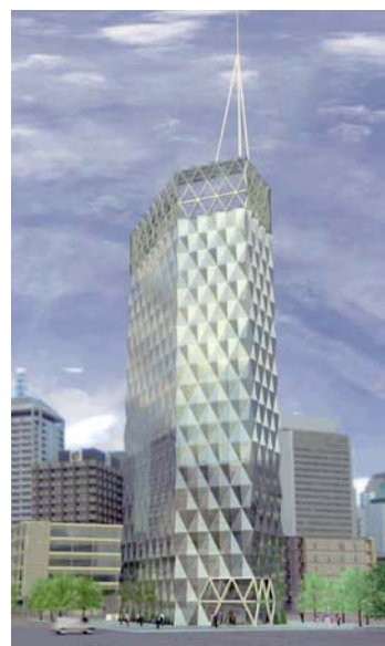
EL PROYECTO DEL PRIMER EDIFICIO CONSTRUIDO COMPLETAMENTE EN ACERO INCLUYE 23 PISOS Y 6 SUBTERRÁNEOS.
